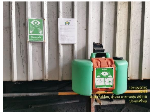
รูปที่ 76 ฝักบัวฉุกเฉิน และอ่างล้างตา
