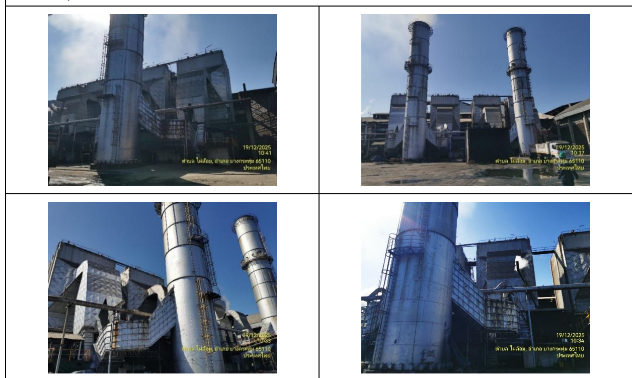
รูปที่ 24 ระบบดักฝุ่นแบบไฟฟ้าสถิตและระบบมัลติไซโคลน
