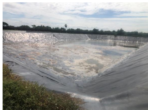
รูปที่ 42 บ่อพักน้ำหลังผ่านการบำบัด (Holding pond)
