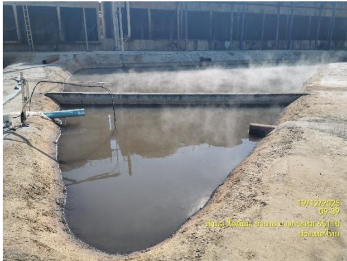
รูปที่ 41 เครื่องตรวจวัดคุณภาพน้ำทิ้งอัตโนมัติ (pH, TDS และอุณหภูมิ) ที่บริเวณบ่อตรวจสอบคุณภาพน้ำทิ้ง (Inspection Tank) ขนาด 50 ลูกบาศก์เมตร บริเวณระบบบำบัดน้ำเสียความสกปรกต่ำ (Low BOD)
