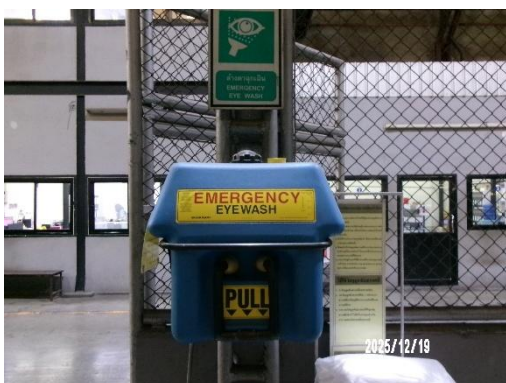
รูปที่ 77 อุปกรณ์ตอบสนองกรณีสารเคมีหกั่วไหล
