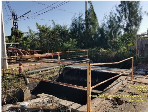
รูปที่ 33 บ่อดักน้ำมัน
