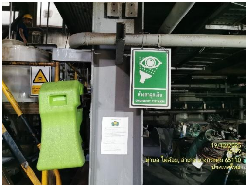
รูปที่ 76 ฝักบัวฉุกเฉิน และอ่างล้างตา
