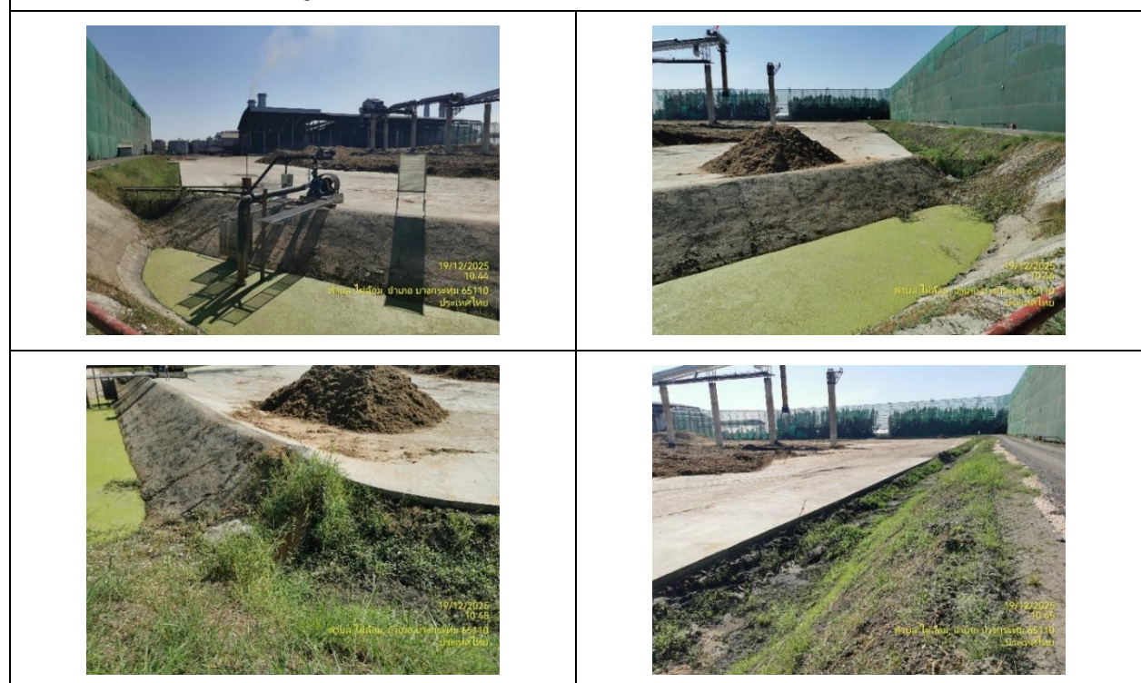
รูปที่ 23 รางระบายน้ำลานกองเก็บกากอ้อย
