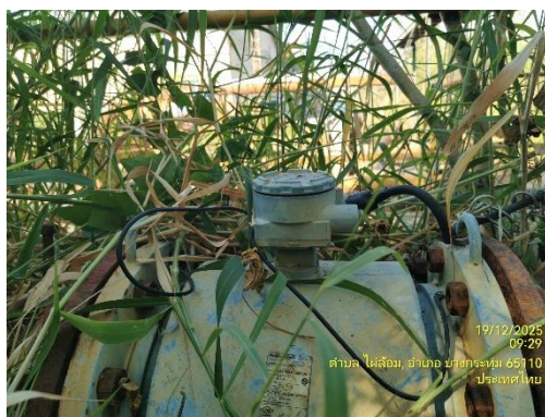
รูปที่ 30 มิเตอร์ตรวจสอบปริมาณน้ำเสีย
