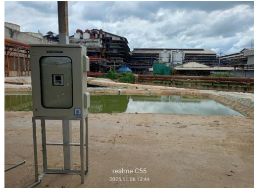
รูปที่ 41 เครื่องตรวจวัดคุณภาพน้ำทิ้งอัตโนมัติ (pH, TDS และอุณหภูมิ) ที่บริเวณบ่อตรวจสอบคุณภาพน้ำทิ้ง (Inspection Tank) ขนาด 50 ลูกบาศก์เมตร บริเวณระบบบำบัดน้ำเสียความสกปรกต่ำ (Low BOD)
