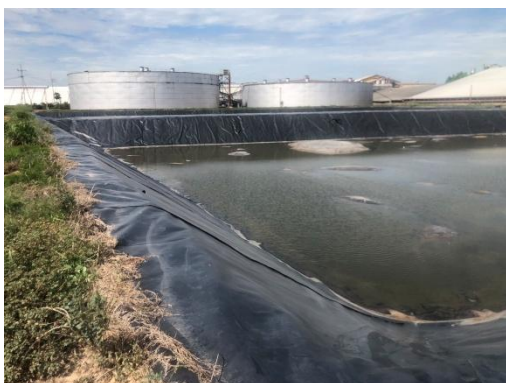
รูปที่ 42 บ่อพักน้ำหลังผ่านการบำบัด (Holding pond)
